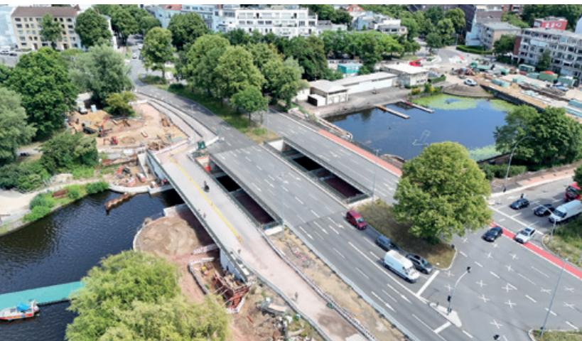
Seit 2020 wurde unter laufendem Verkehr gebaut. Kernmaßnahmen waren der **Neubau von zwei Straßenbrücken** sowie einer **Geh- und Radwegebrücke**, die Querungen sicherer und direkter machen. Der bisher enge Durchlass zur Außenalster wurde erweitert, und der Fußgängertunnel unter der Sechslingsporte
